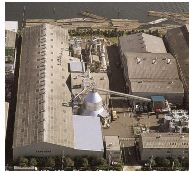
新木場リサイクリング工場
